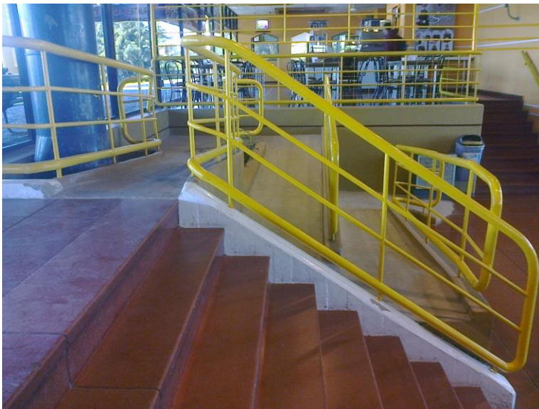
Foto 4. Creación de nuevas rampas en la Terminal de ómnibus.
